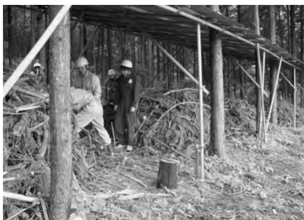
図5 設置した簡易屋根
