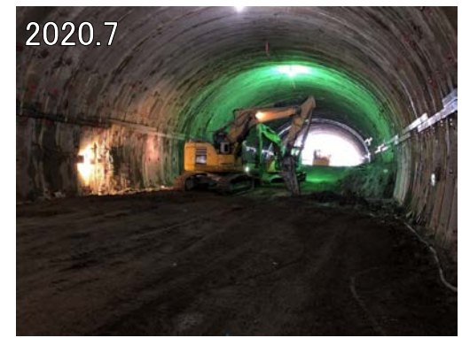
トンネル インバート工施工状況 (下八木沢第一トンネル)
